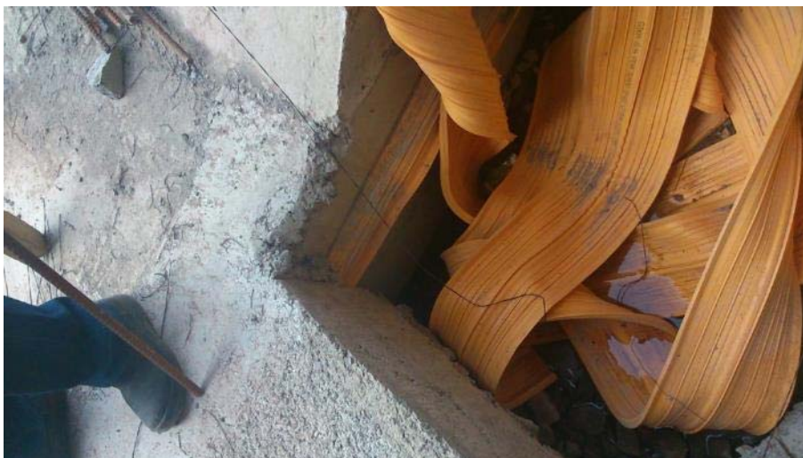
Foto 71 – Detalhe da junta Fungenband dobrada
