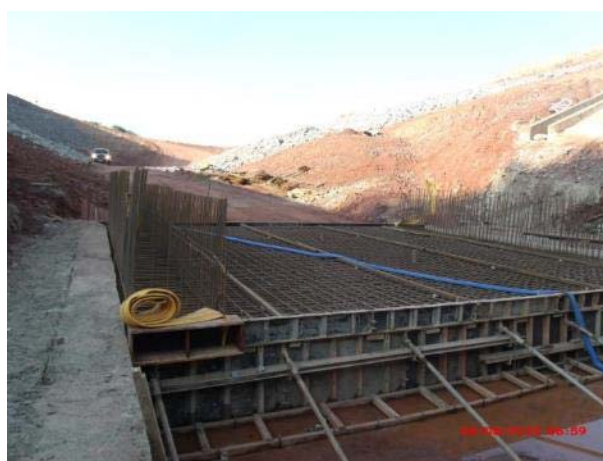
Foto 19 – Visualização da armação do 3º bloco antes da concretagem – WBS 1410.
