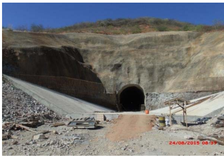
Foto 50 – Concluído a armação de ferragem dos taludes para concretagem
