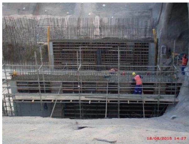
Foto 37 – Execução da concretagem das paredes do bloco 1- Túnel Falso – Emboque Cuncas I.
