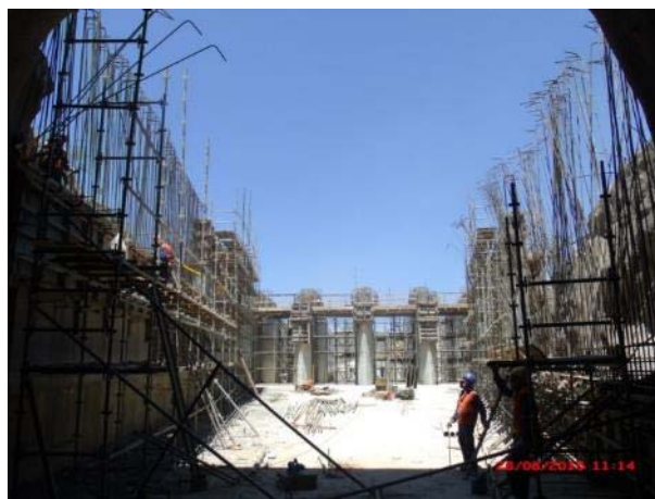
Foto 53 – Armação de ferragem do L.E. H e L.D. H do paredão da transição da estrutura de controle.
