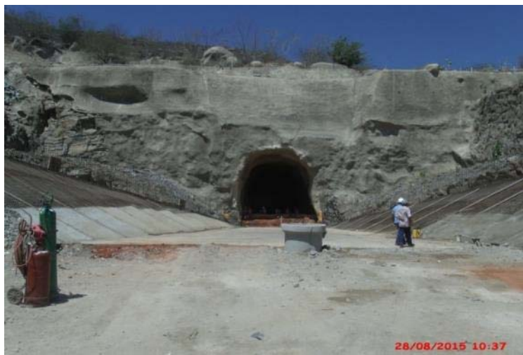
Foto 47 – Concretagem dos taludes
