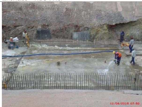
Foto 32 – Cura do concreto da laje de fundo do bloco 2.
