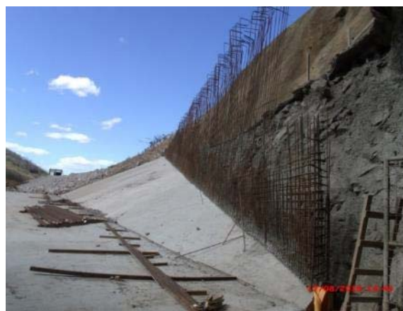
Foto 49 – Concretagem do talude lateral
