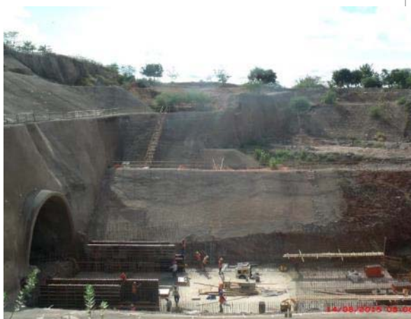
Foto 35 – Armação das paredes dos blocos 1 e 3.
