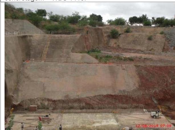
Foto 31 – Conclusão das concretagens da laje de fundo do túnel falso – WBS 1410.
