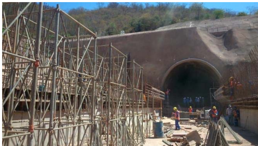
Foto 58 – Execução da parede esquerda do túnel falso
