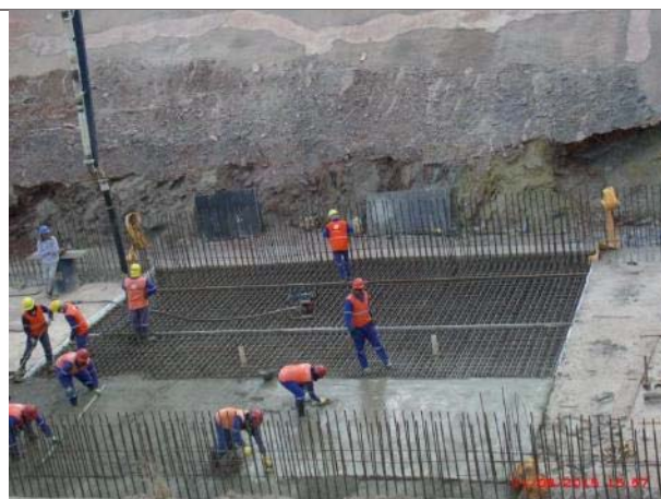
Foto 30 – Concretagem da laje de fundo do 2º bloco do túnel falso – WBS 1410.
