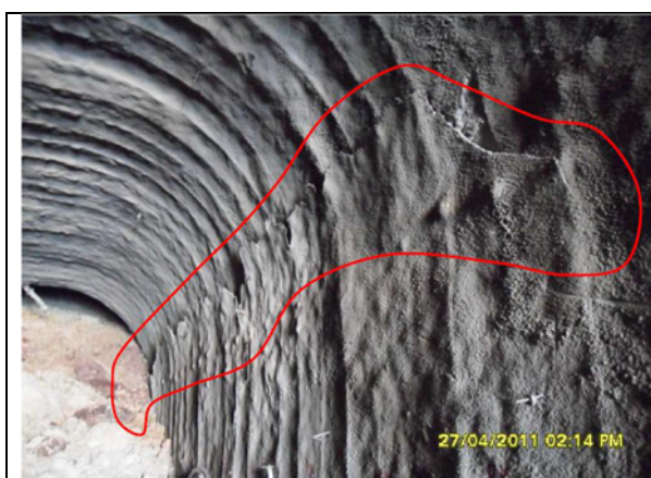
Foto 1 – Trinca no encontro da calota com o pé-direito.
