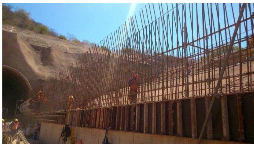
Foto 57 – Execução da parede direita do túnel falso
