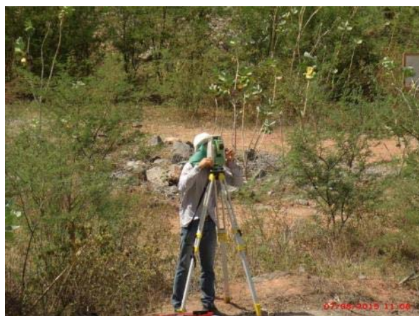
Foto 25 – Túnel Cuncas I, leitura dos marcos superficiais. – WBS 1410.
