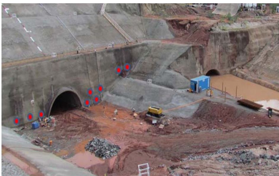
Foto 9 – Locação dos DHP's nos taludes
