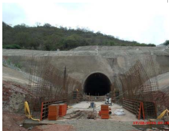
Foto 36 – Armação das paredes dos blocos 1 e 3.
