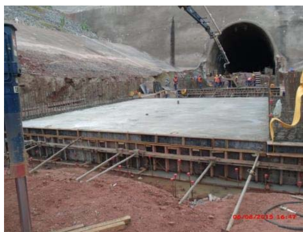
Foto 20 – Concretagem da laje de fundo do 3º bloco do túnel falso – WBS 1410.
