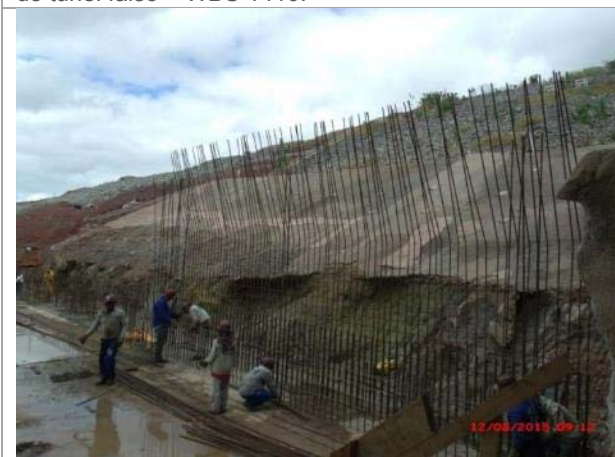
Foto 33 – Início da armação das paredes do bloco 1.
