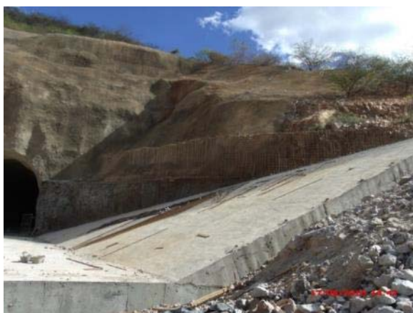
Foto 48 – Concretagem do talude lateral
