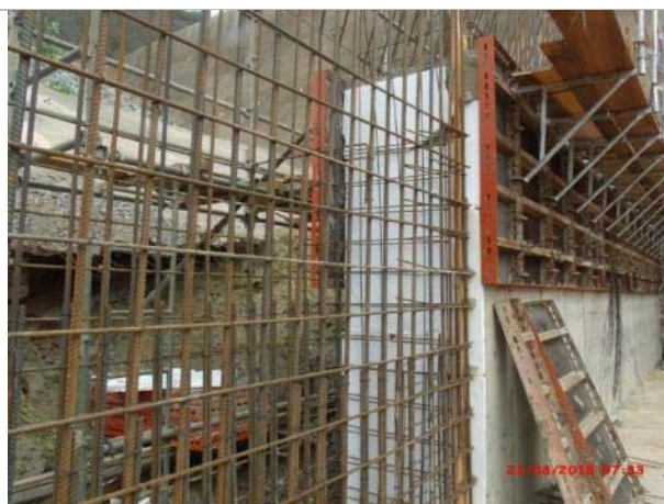
Foto 42 – Vista da instalação da junta de dilatação entre os módulos das paredes
