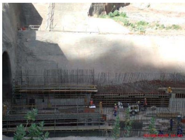
Foto 39 – Execução da concretagem das paredes do bloco 2- Túnel Falso – Emboque Cuncas I.
