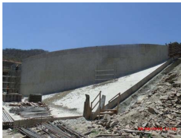
Foto 54 – Conclusão da laje, talude e muro do L.D. H da transição da estrutura de controle.
