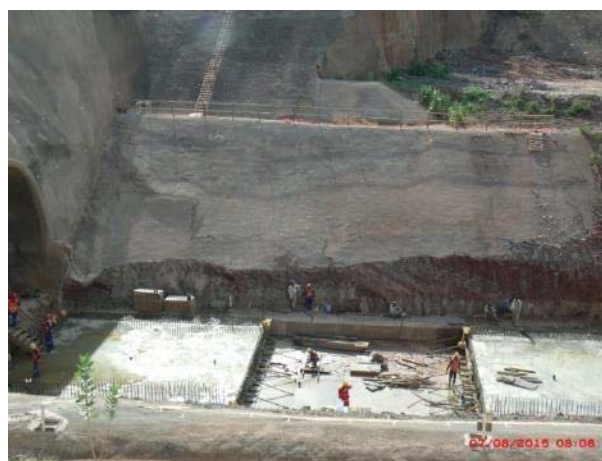
Foto 22 – Lajes de fundo dos Blocos 1 e 3 concretadas– WBS 1410.
