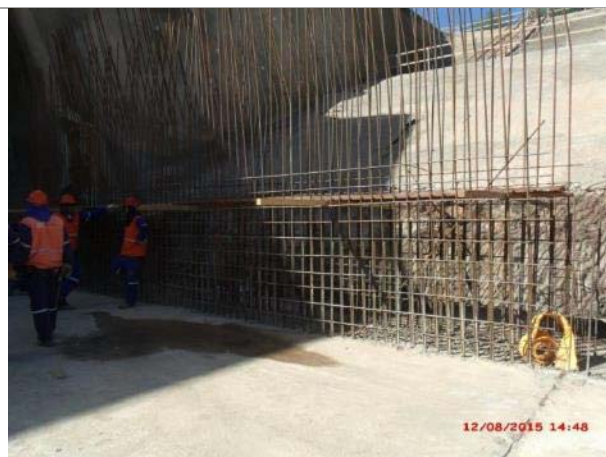
Foto 34 – Início da armação das paredes do bloco 1.
