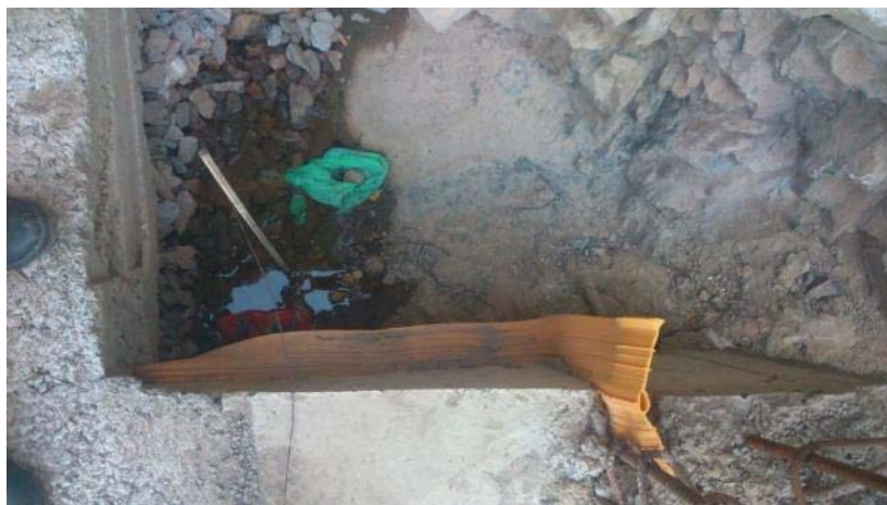
Foto 70 – Detalhe da junta Fungenband dobrada
