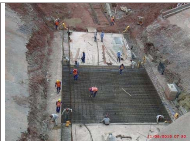
Foto 29 – Visualização da armação do 2º bloco antes da concretagem – WBS 1410.
