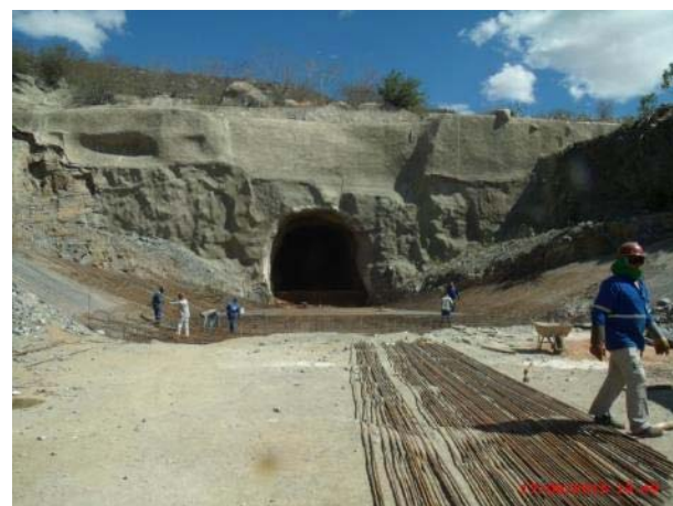
Foto 45 – Montagem da ferragem da laje de fundo da transição entre o canal WBS1235 e entrada do túnel.
