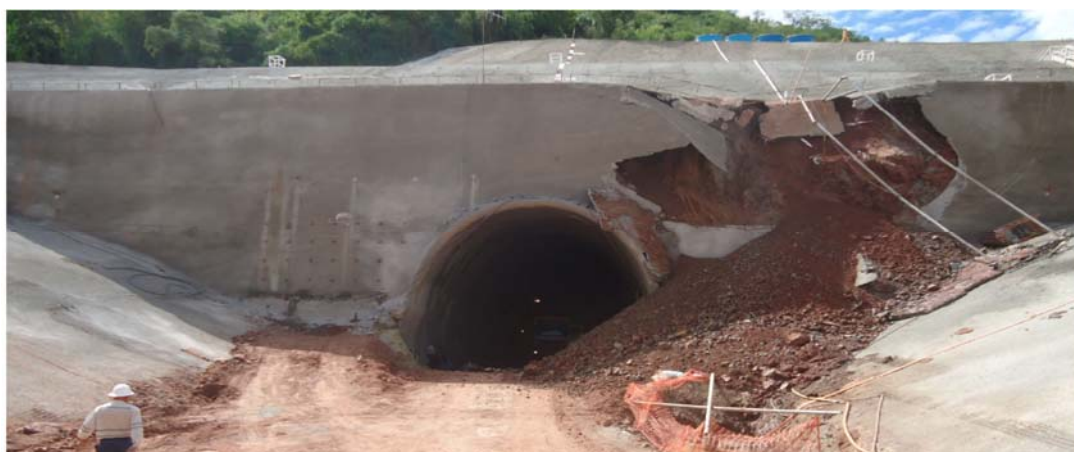
Foto 5 – Foto da ruptura local no espelho do emboque do túnel Cuncas I
