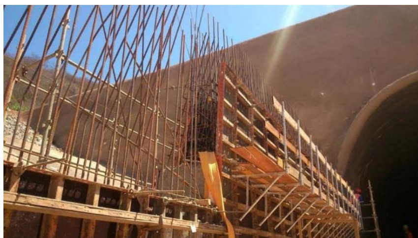
Foto 59 – Detalhe da junta de dilatação entre os módulos do túnel falso
