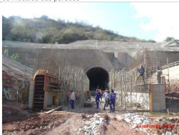
Foto 44 – Vista geral da construção do túnel falso
