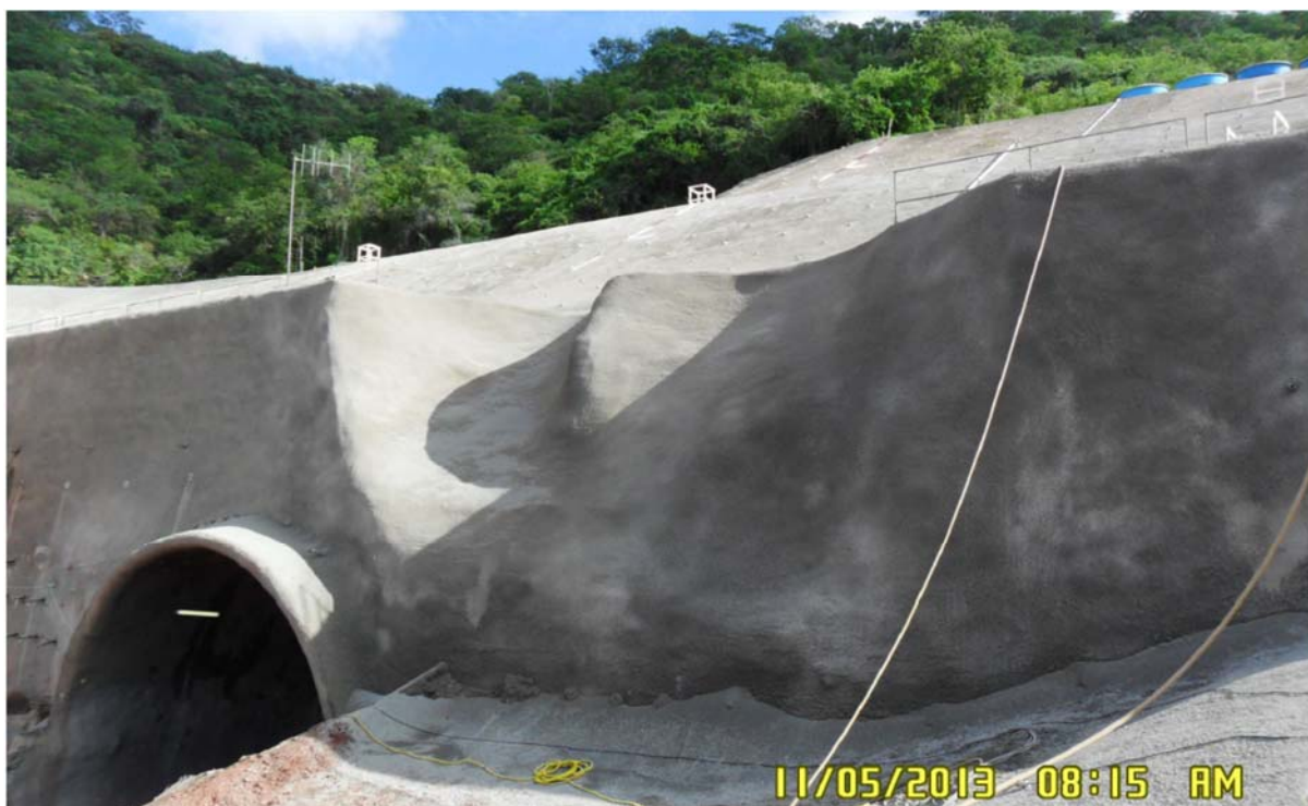
Foto 8 – Local da ruptura reforçado
