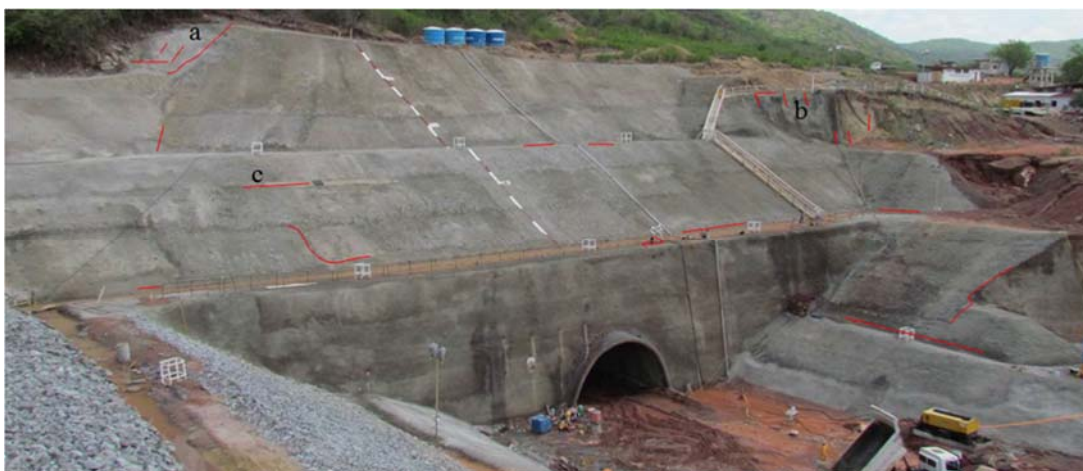
Foto 3 – Locação das trincas nos taludes
