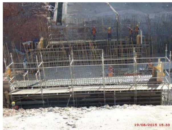
Foto 38 – Execução da concretagem das paredes do bloco 3- Túnel Falso – Emboque Cuncas I.
