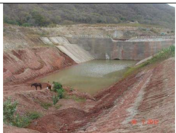
Foto 2 – Emboque após a ruptura
