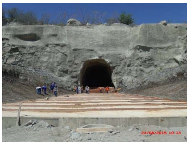
Foto 46 – Montagem da ferragem dos taludes direito e esquerdo da transição entre o canal WBS1235 e entrada do túnel.
