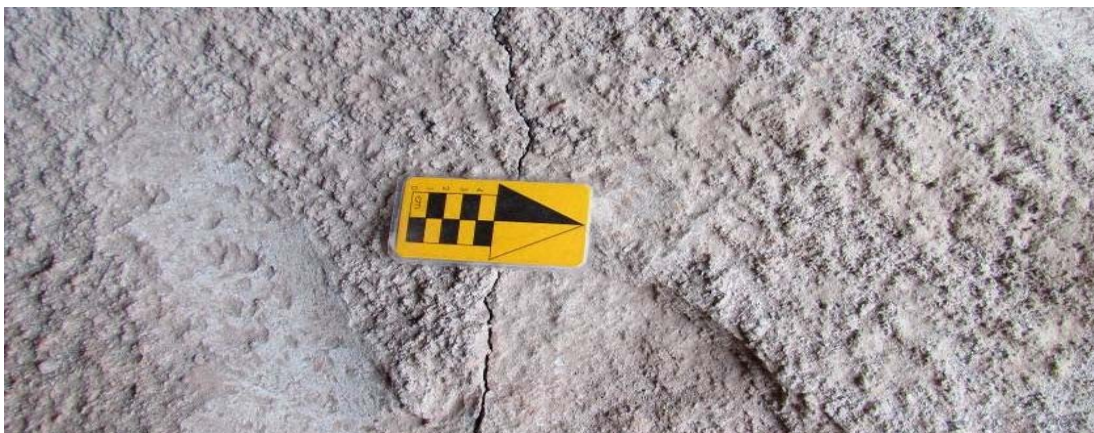
Foto 4 – Emboque do Cuncas I – Fissura no interior do túnel
