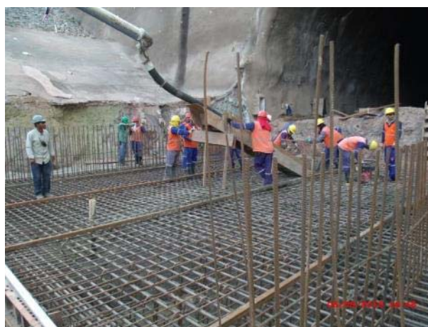
Foto 21 – Concretagem da laje de fundo do 1º bloco do túnel falso – WBS 1410.
