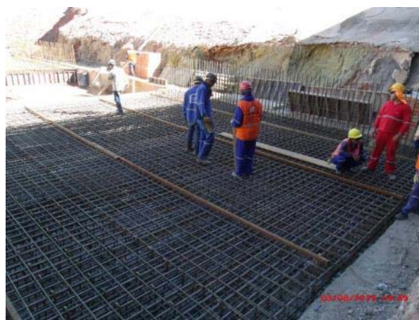
Foto 16 – Vista da armação da laje do bloco 1 do túnel falso. – WBS 1410.
