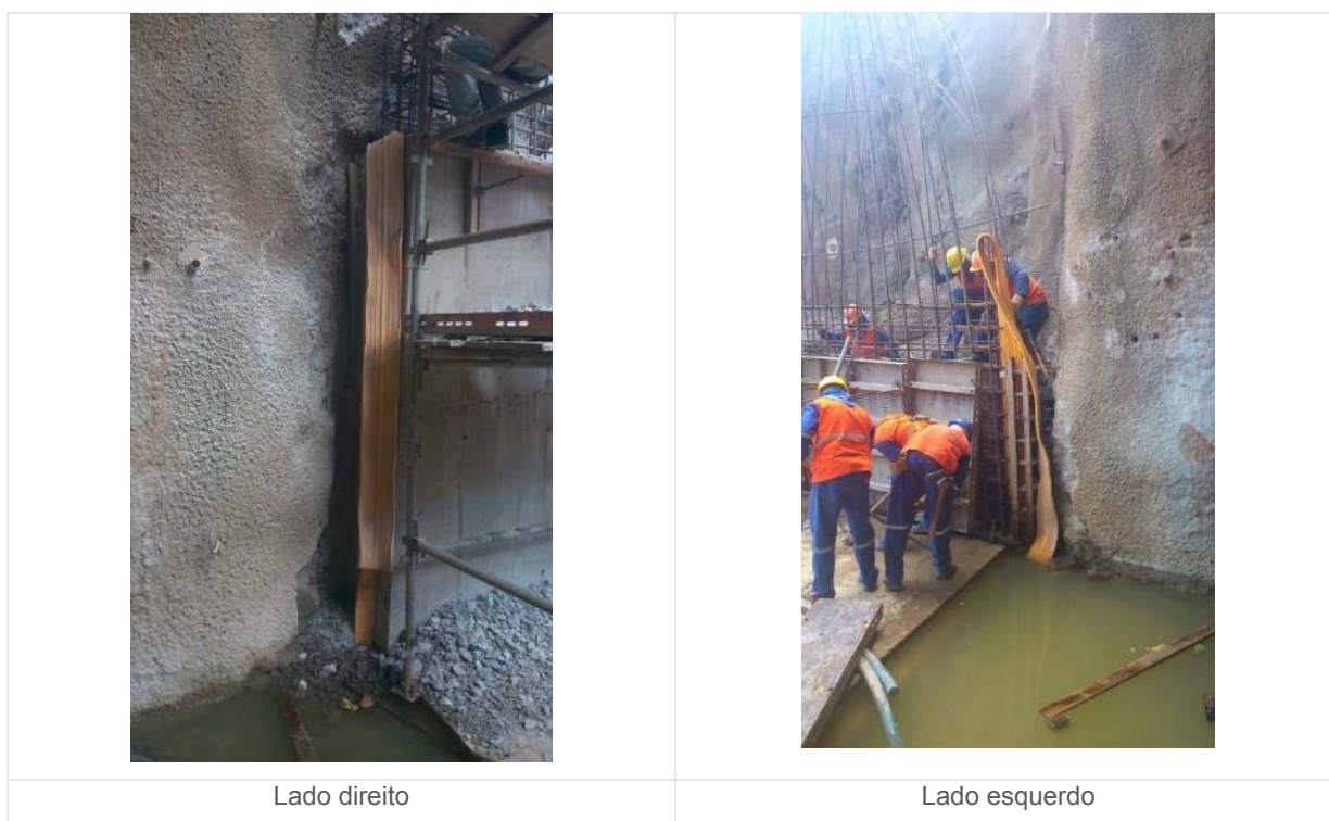
Foto 67 – Detalhe do encontro entre o túnel escavado e a estrutura de transição
